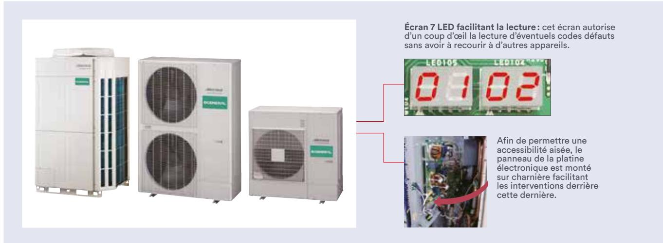
Les codes erreurs peuvent être aussi contrôlés via la commande filaire des unités intérieures.
